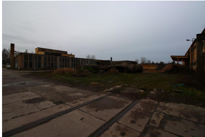
Abb. 2: Fabrikinnenhof, südlicher Abrissbereich für Ein- Mehrfamilienhäuser
