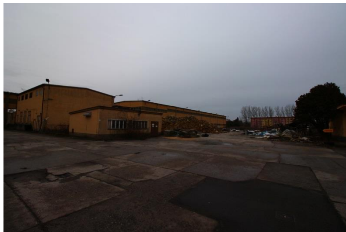
Abb. 6: nördliche Abrissgebäude, geplanter Standort für einen Kindergarten sowie Ein-, bzw. Mehrfamilienhäuser (an Einfahrt zum Gelände)
