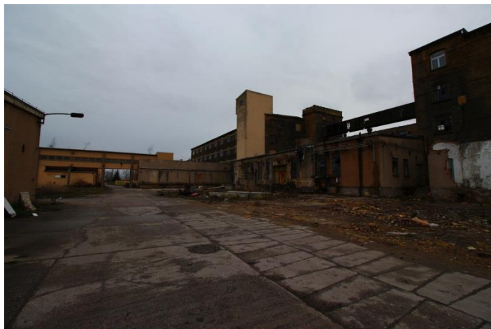
Abb. 1: Fabrikinnenhof Richtung Betriebseinfahrt, Sanierungsbereich
